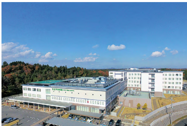
▲公立甲賀病院全景
